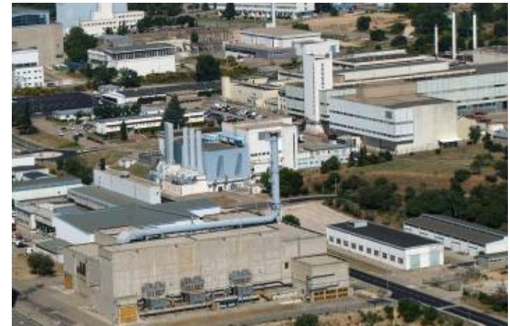
L'usine UP1 et les installations associées en cours d'assainissement
